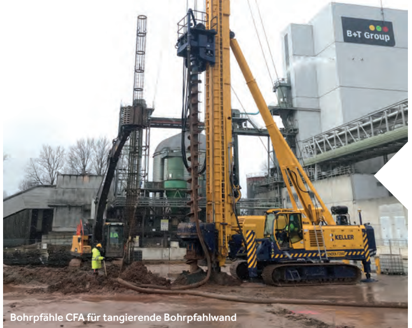
Tangierende Bohrfahlwand mit Bohrpfählen CFA nach Aushub
