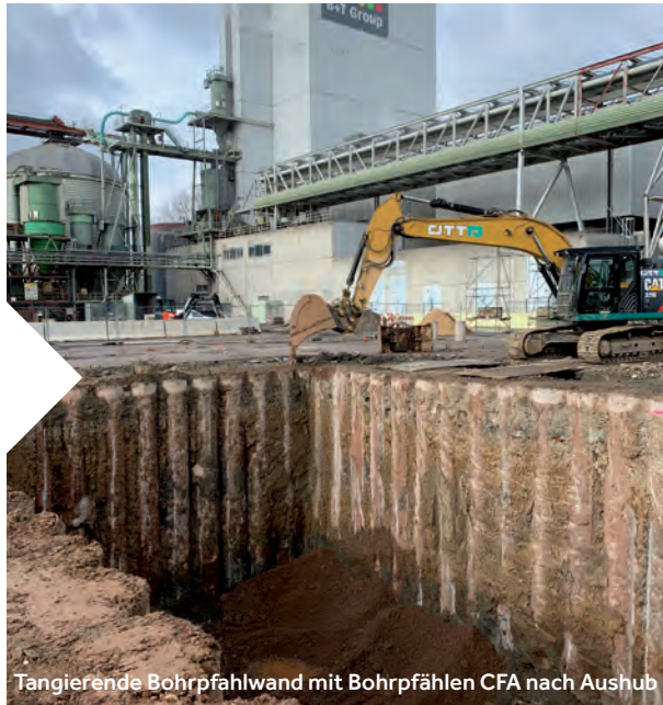
Bohrpfähle CFA für tangierende Bohrfahlwand
